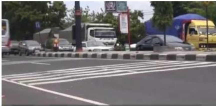
Gambar 50. Pemasangan Rumble Strip
