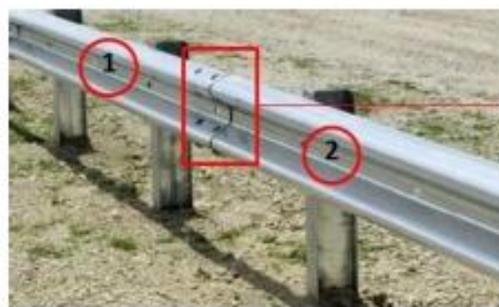
Gambar 13. Metode Penyambungan Beam tampak samping
