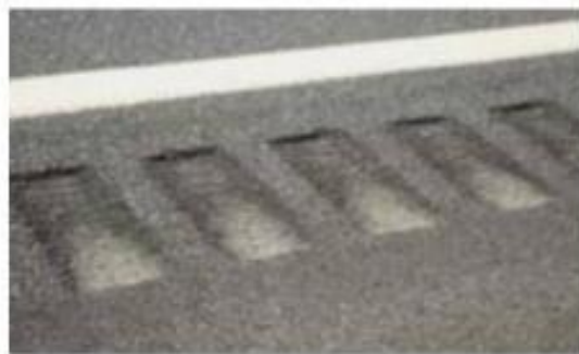
Gambar 51. Pemasangan Soulder rumble
