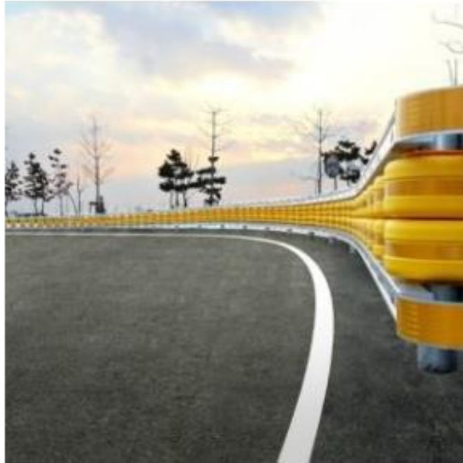
Gambar 28. Pemasangan Safety Roller di tikungan jalan
