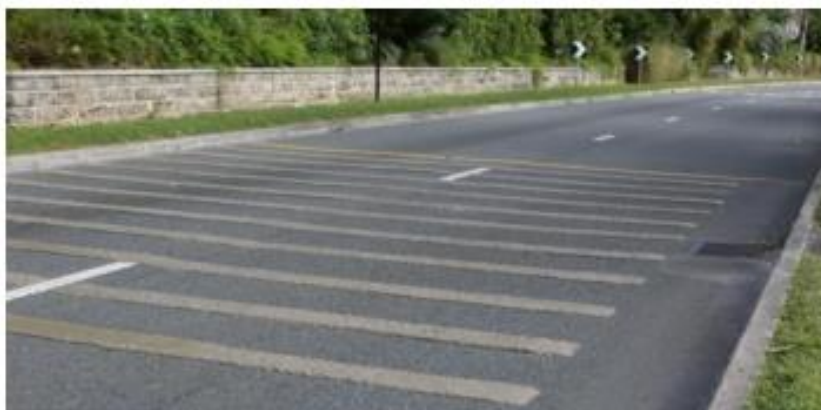
Gambar 52. Pemasangan Rumble Area
