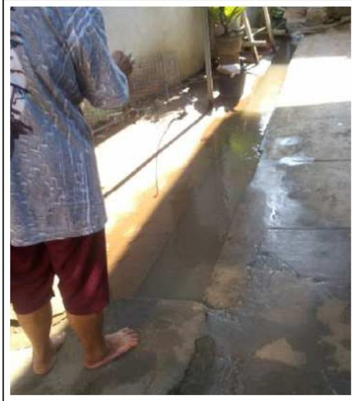
Gambar 8. Kondisi Saluran Drainase yang Tidak Terhubung dengan Sistem Drainase Perkotaan Sehingga Menimbulkan Genangan
