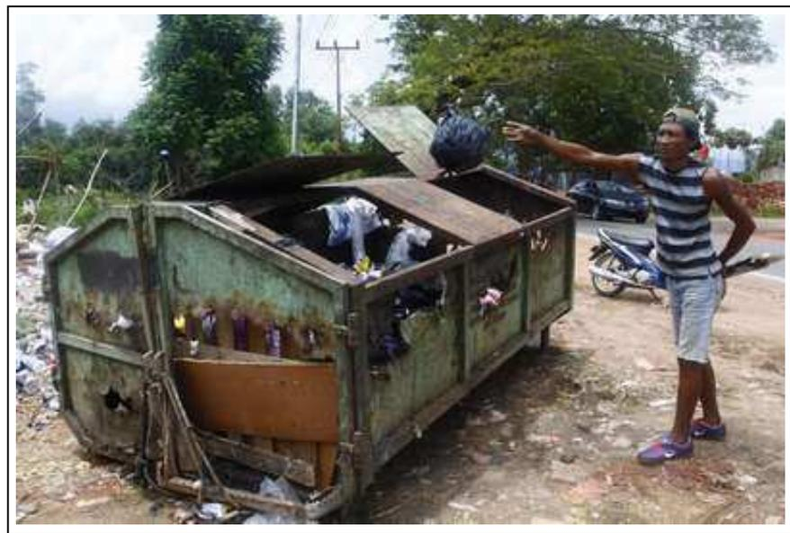
Gambar 15. Bak Sampah yang Tidak Terpelihara (Rusak Konstruksinya)
