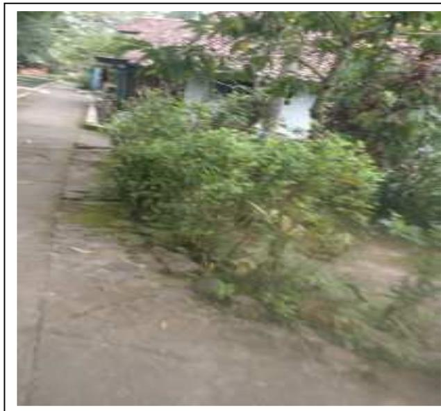
Gambar 7. Kondisi Jalan yang Tidak Dilengkapi Saluran Drainase
