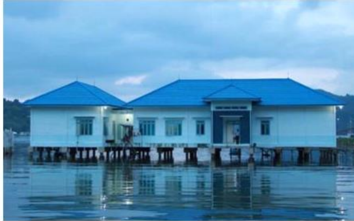
Gambar 14. Contoh Bangunan Pengawasan di atas air
