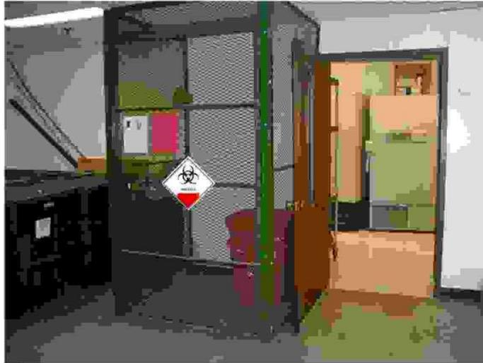
Gambar 1. Contoh fasilitas penyimpanan Limbah B3 dari fasilitas pelayanan kesehatan dalam ruangan yang dilengkapi dengan pembatas akses (kerangkeng).
